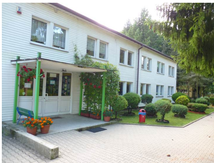
Zdjęcie. Budynek przedszkola – widok od strony północnej.
