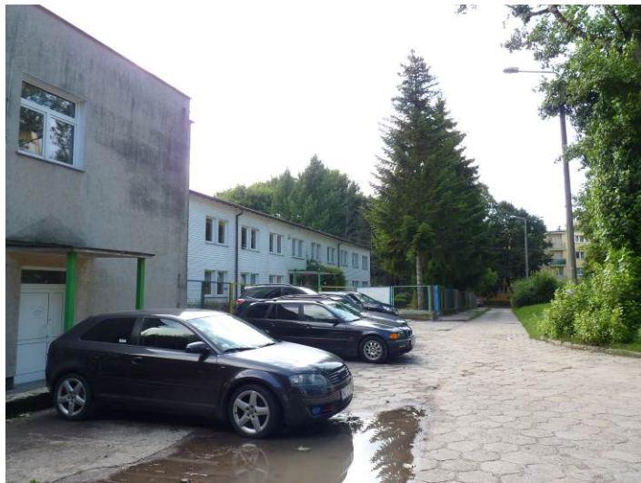
Zdjęcie. Droga dojazdowa do przedszkola miejskiego w części północnej terenu objętego opracowaniem.
